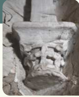
Das Portal im Erdgeschoß der westlichen Empore
