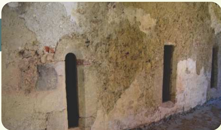
Die erhaltenen Luken in dem Obergeschoss des westlichen Trakts
